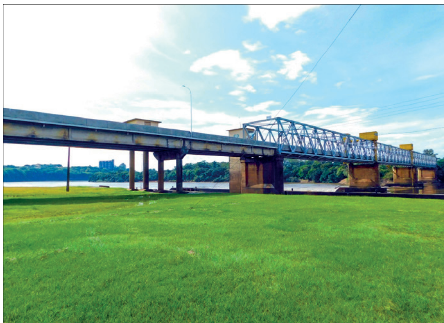
Ponte do Fandango sobre o Rio Jacuí, na BR-153/RS
